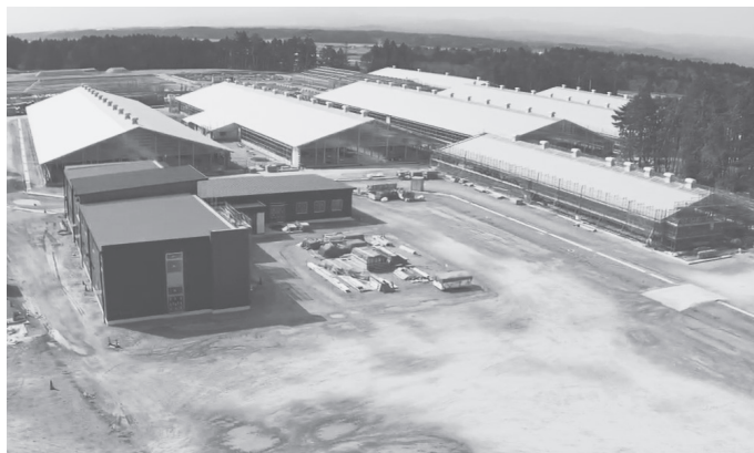
牧場建設状況
